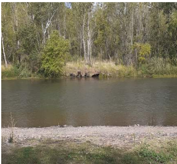
Figura 11 Erosión fluvial. Balneario Sandra Canale
