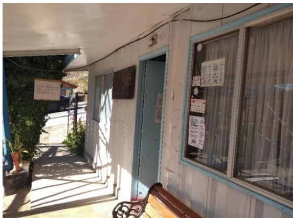
Figura 5. En la fotografía se muestra parte de la estructura de la posta rural de Pedregal, comuna de Monte Patria, provincia del Limari, Región de Coquimbo, Chile. Fuente: (Elaboración propia, 2019).
