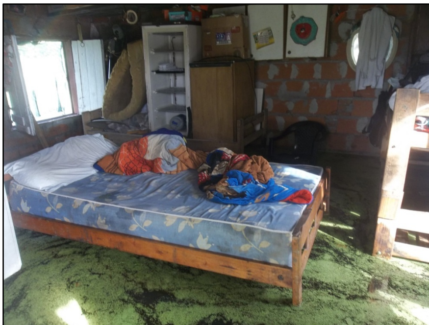
Figura 8. Anegamiento en casas construidas en lagunas (Corrientes, Argentina). Fuente: Base de datos personal. 22 de Mayo de 2014.
