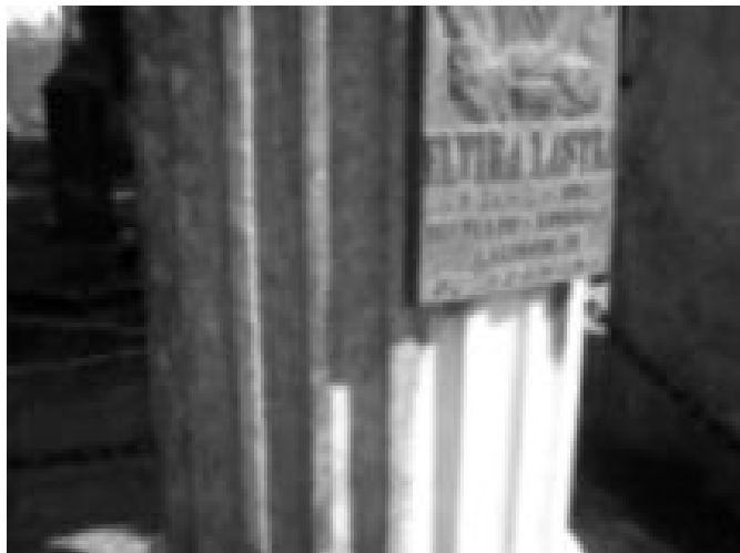
Fig. 3. Columna del cementerio de La Plata con algas y hongos.
