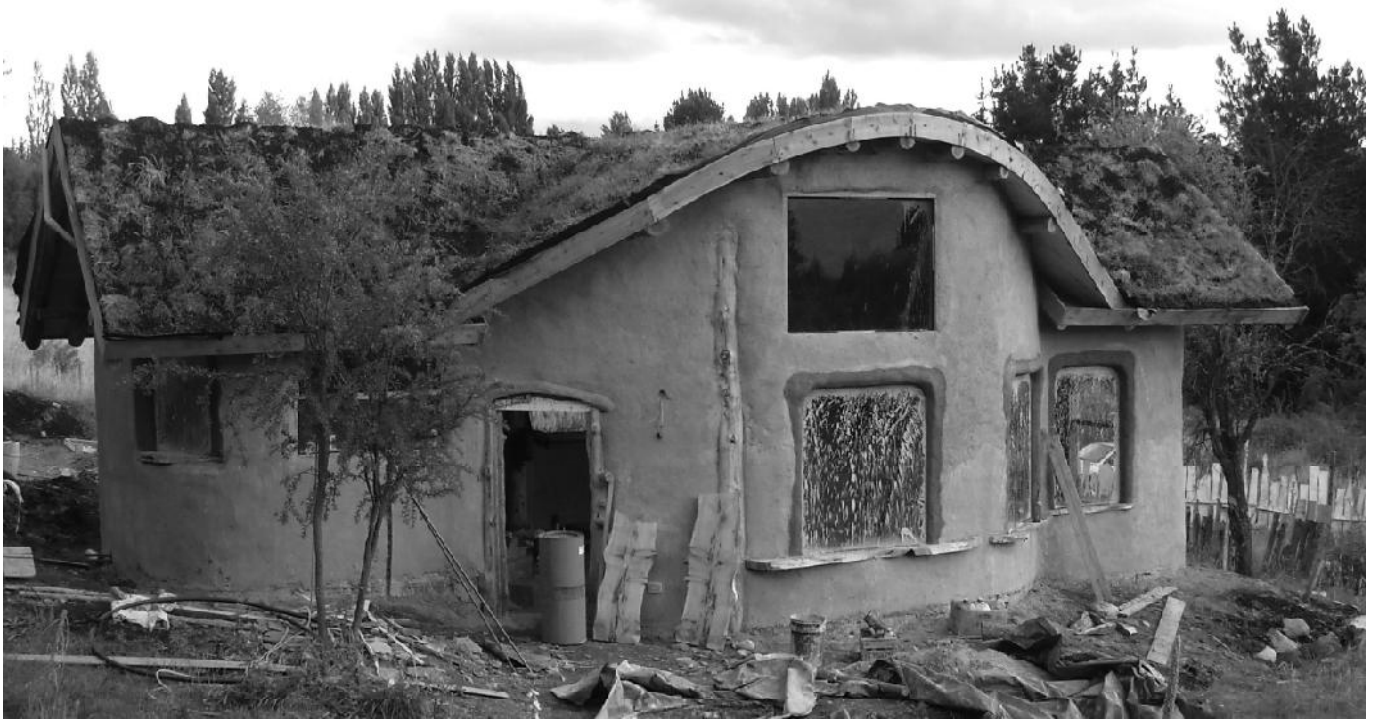
Figura 2. Casa con envoltente de bloques de paja y arcilla, revocada con arcilla y arena, en etapa de terminación.
