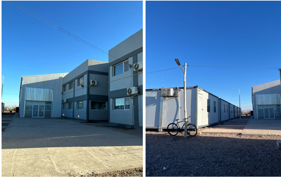
Imágenes 02 y 03. Edificio actual de la escuela técnica de Añelo.
